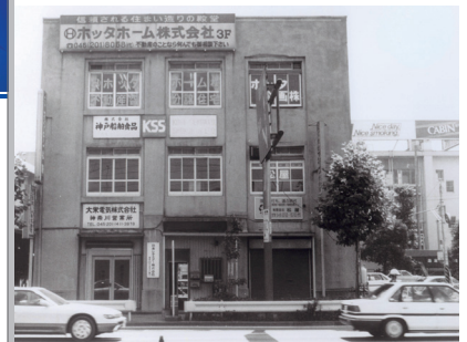
横浜学院を開設した松本会館（1928年撮影）
